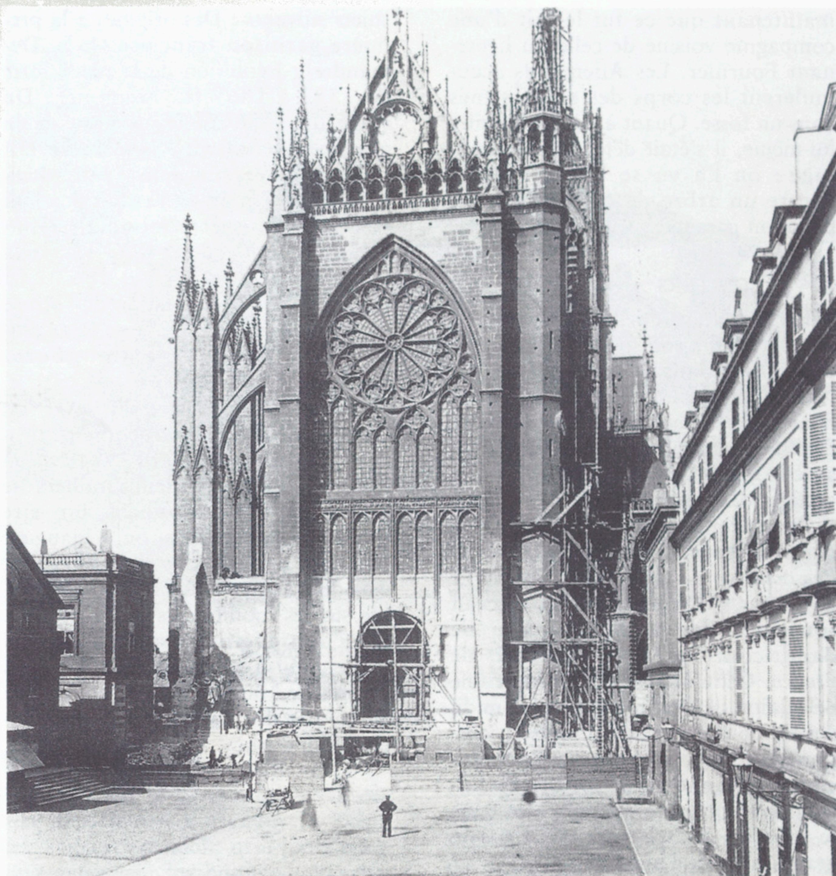
Façade occidentale de la cathédrale de Metz vers 1899 après l'édification du pignon néogothique, pendant la démolition du portail de Blondel, et avant la construction du portail de Tornow.
