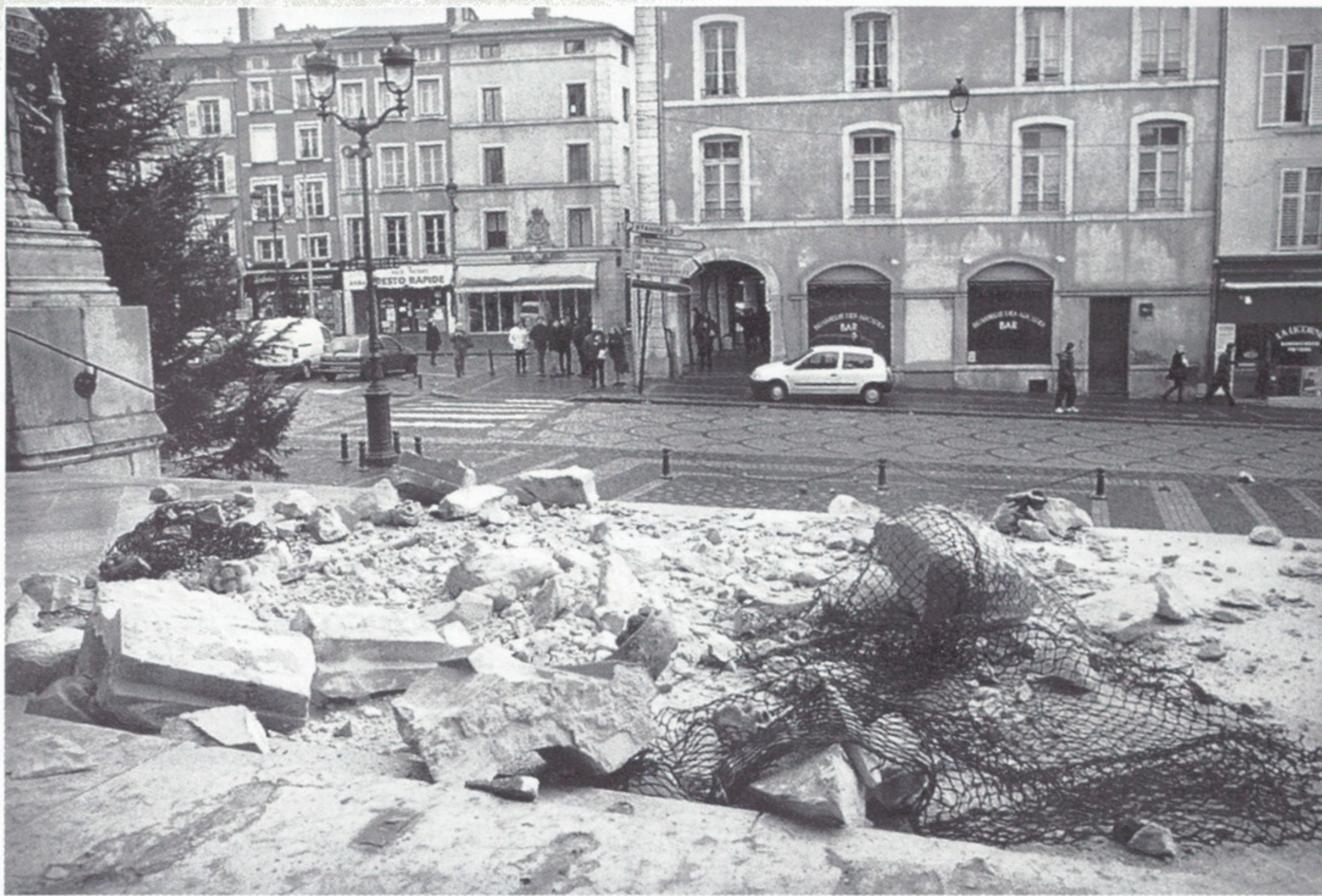
Devant l'église Saint-Epvre, l'amas des pierres descellées par la tempête. Photo Est Républicain
