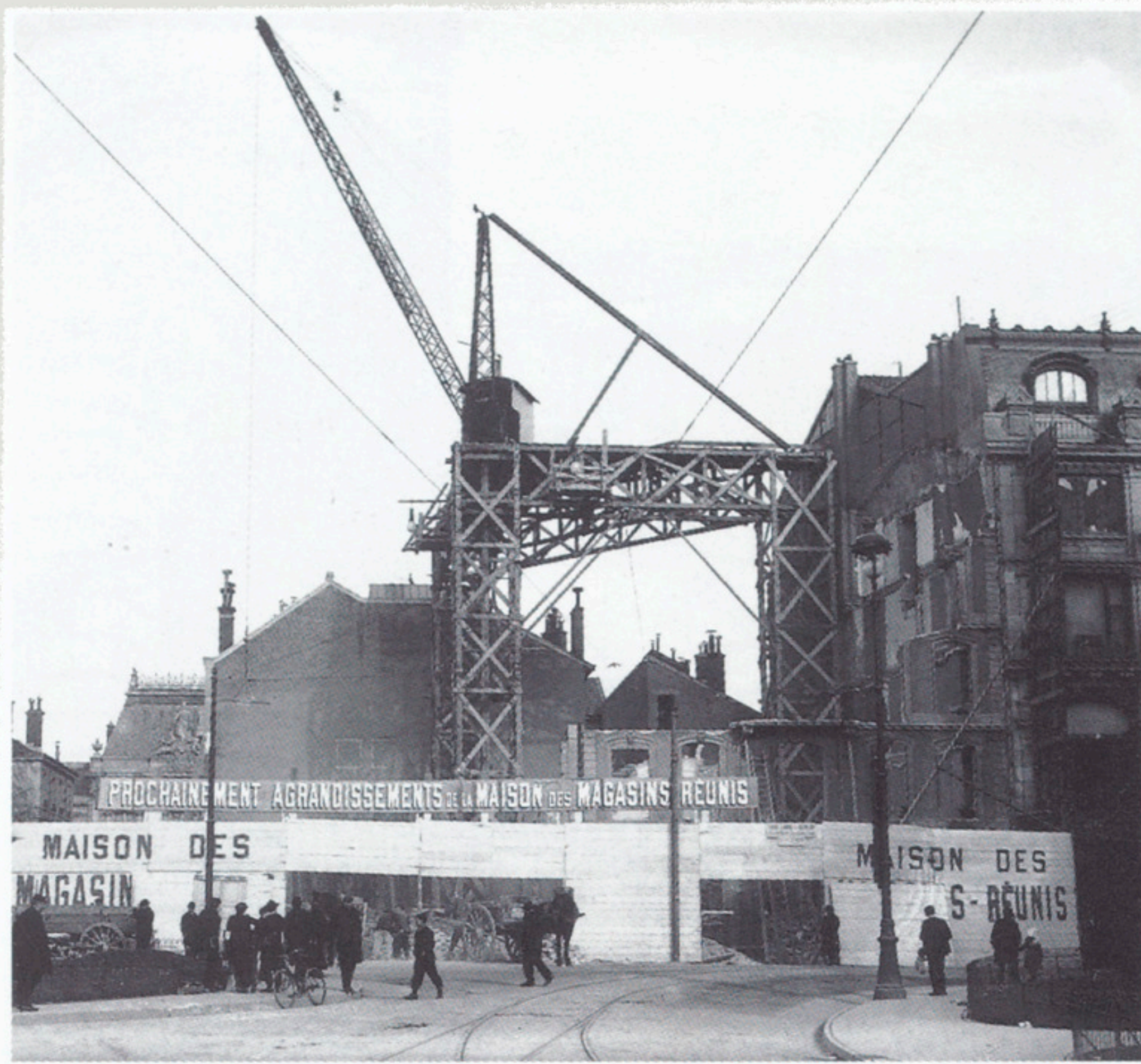
Les travaux d'agrandissements rue Mazagran, face à la gare, avec la grue « Derrick » © Inventaire Général
