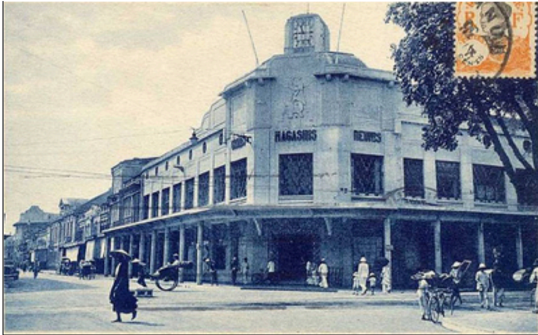
Grands Magasins réunis, rue Paul-Bert, Hanoï Un des petits campaniles a disparu pour faire place à une horloge lumineuse à trois cadrans (1933)
